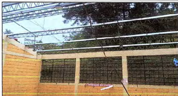
Foto 2: ESTRUCTURA DE TECHO
